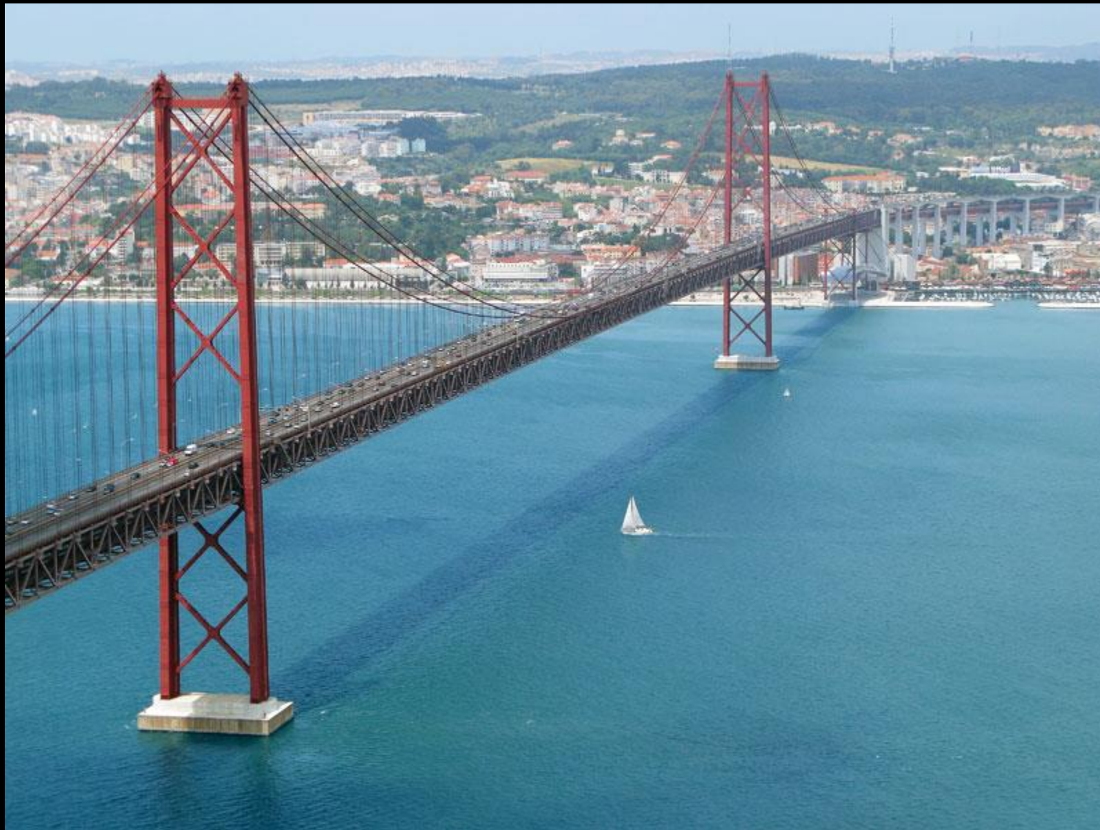
Ponte 25 de Abril, Lisbon
