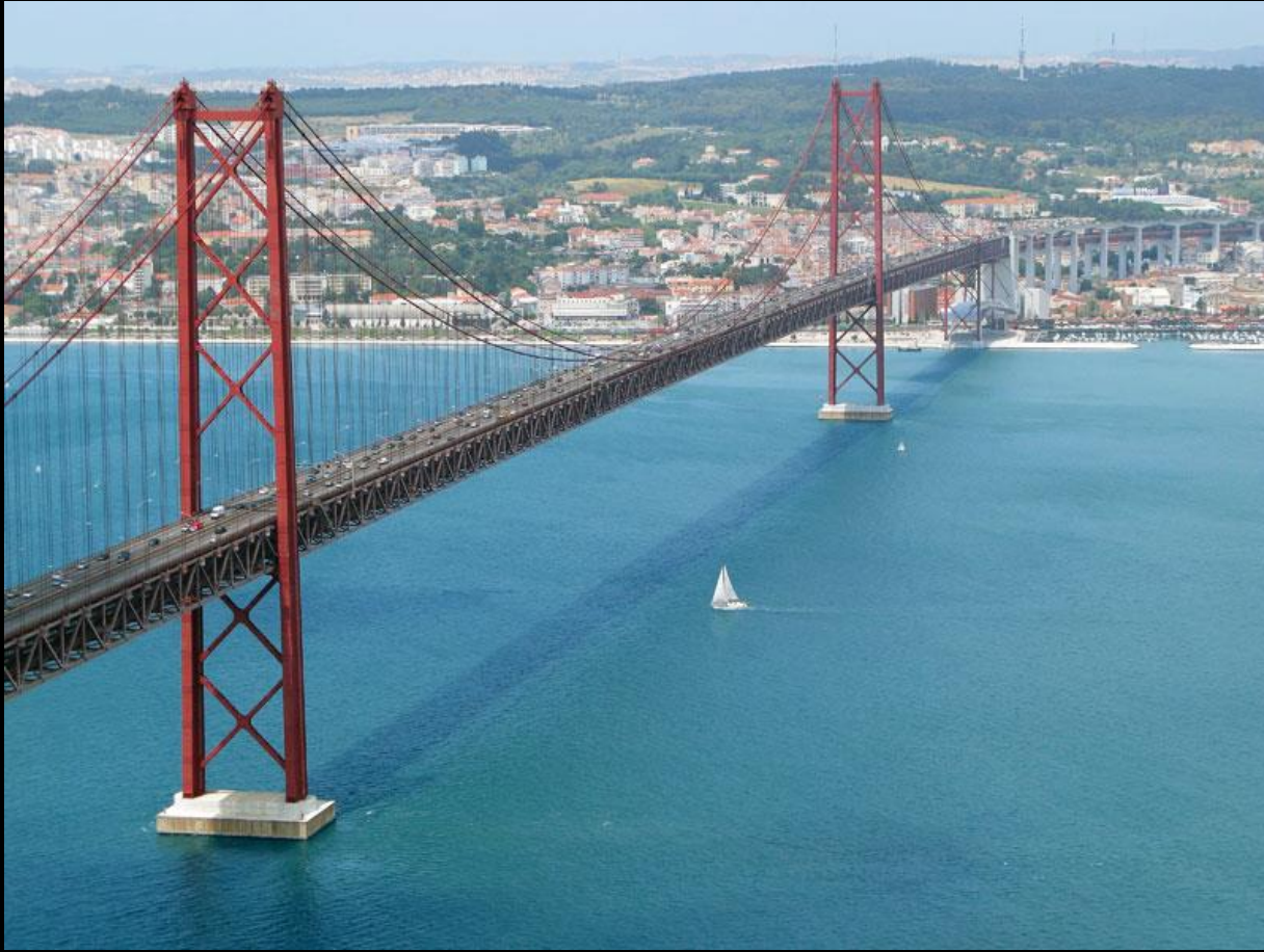
Ponte 25 de Abril, Lisbon
